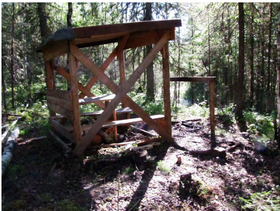
Фото 30. Навес в районе пикета 15,4 км.
